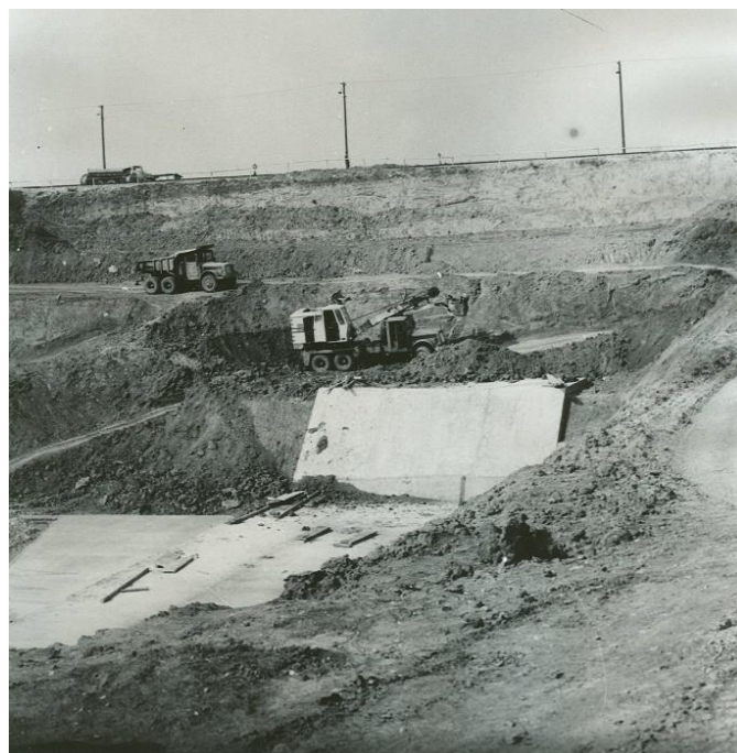
Výkop hlavného výrobného bloku V1, r. 1973
