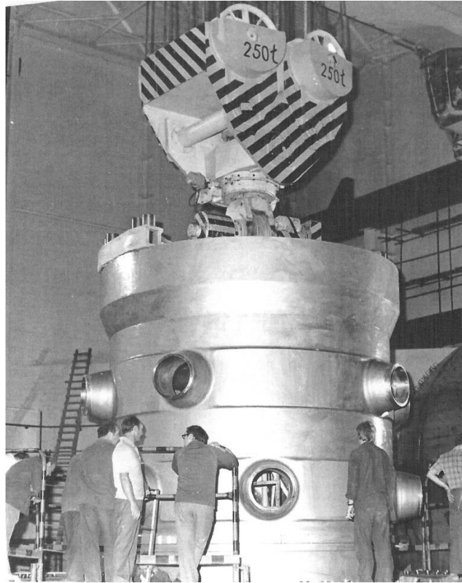
Montáž tlakovej nádoby reaktora V1
